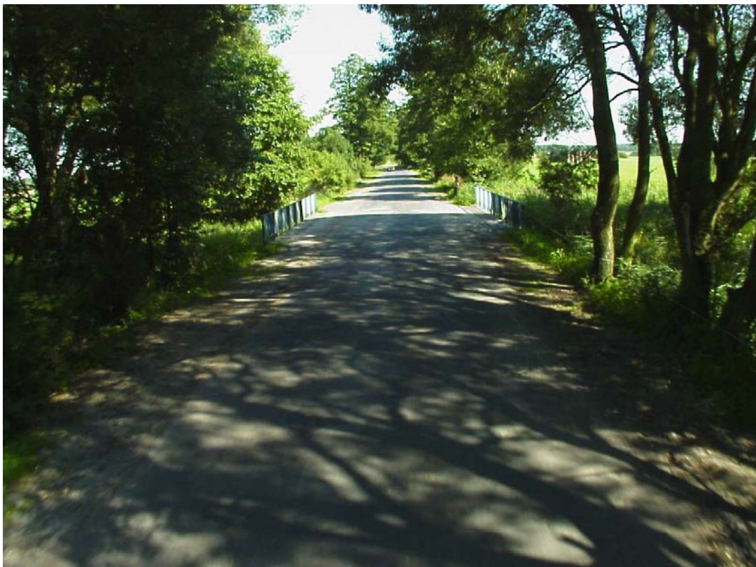
Rys.: droga powiatowa nr 1025S przed przebudową
