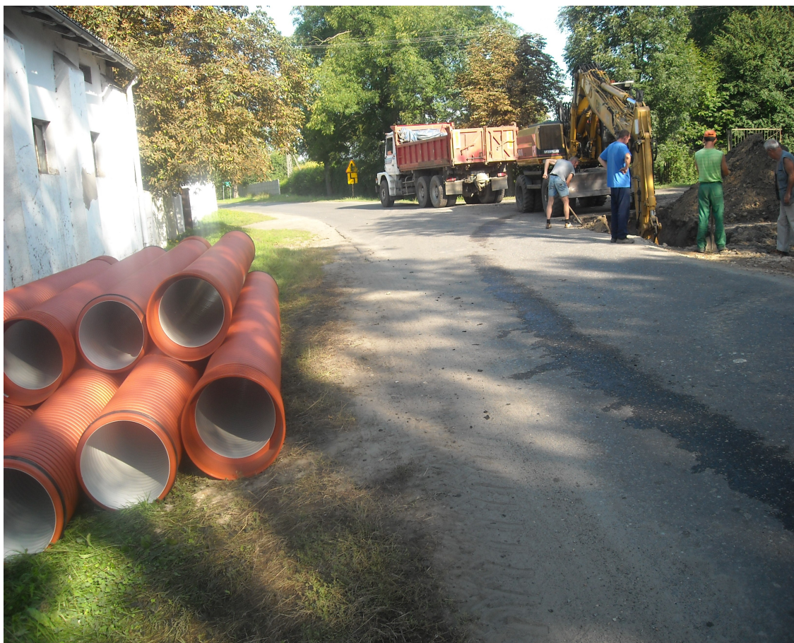
Rys.: Droga powiatowa 1025S w trakcie przebudowy
