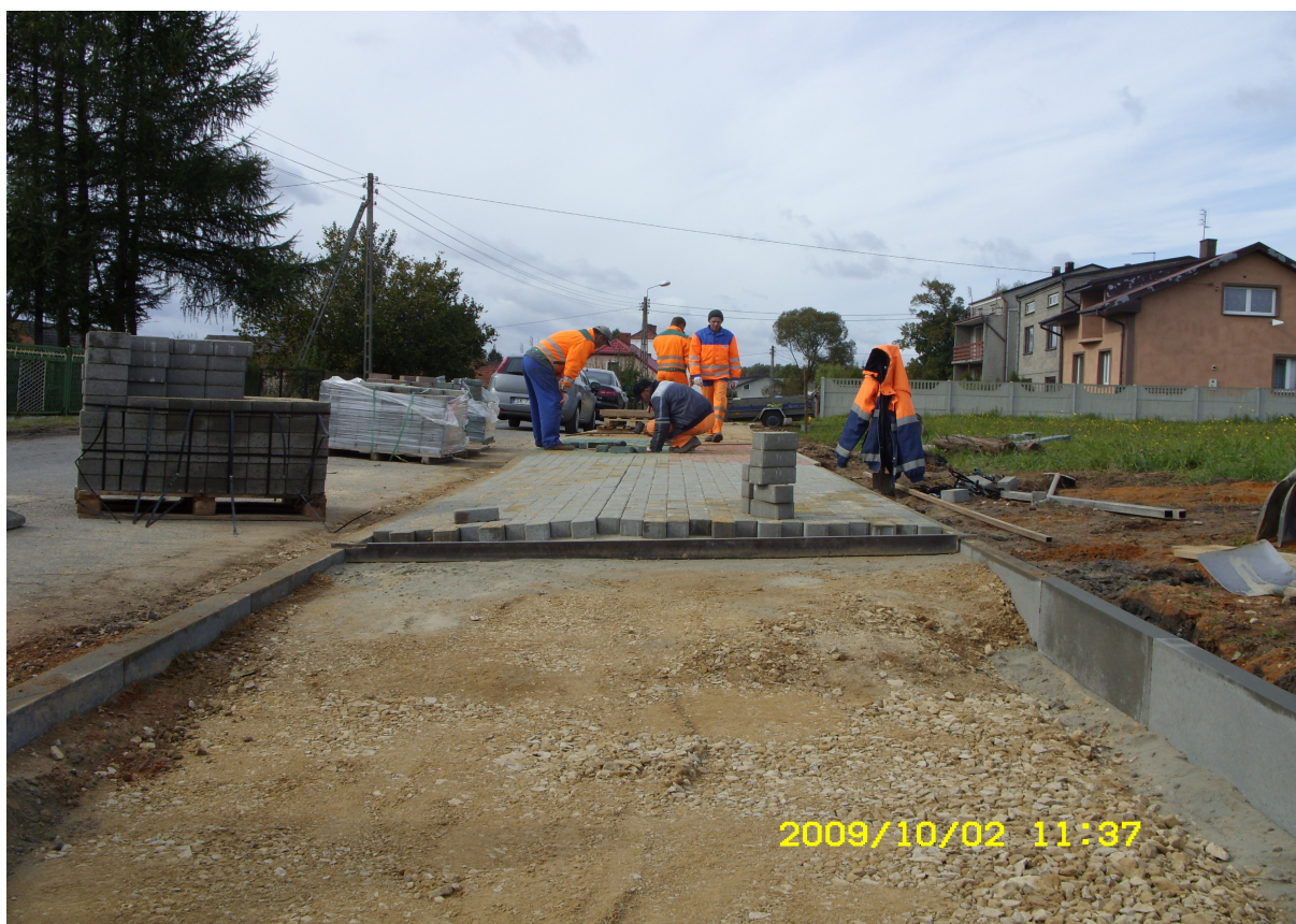
Rys.: Droga powiatowa w trakcie przebudowy
