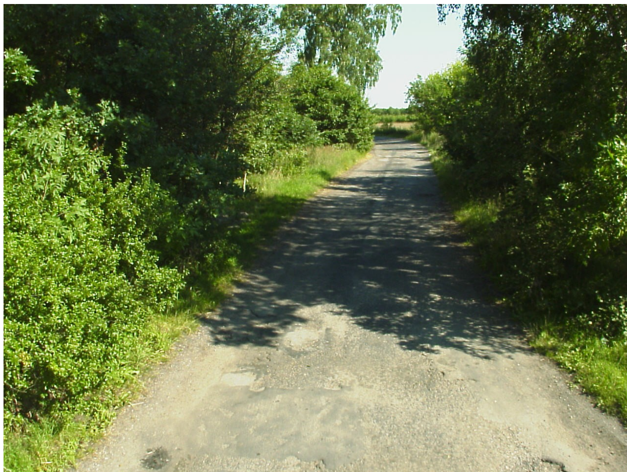
Rys.: Droga powiatowa przed przebudową
