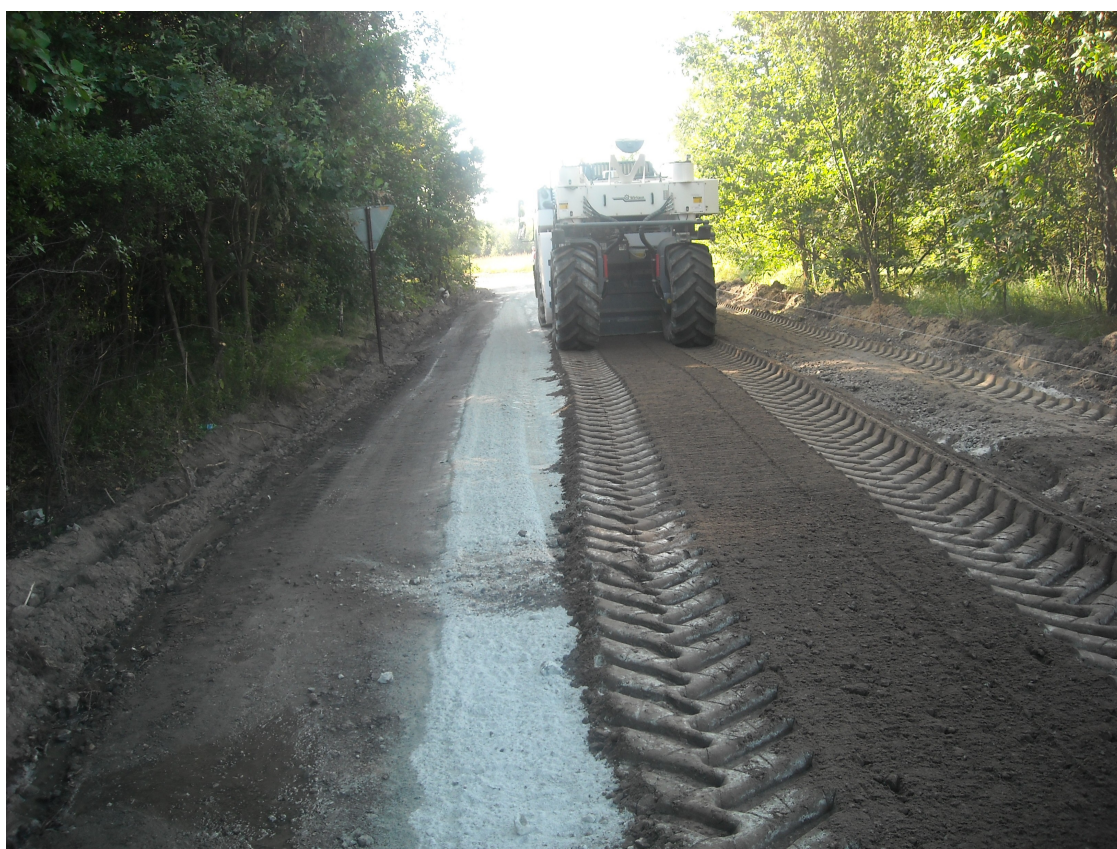
Rys.: Drogi powiatowe nr 1031 S i 1032 S w trakcie przebudowy
